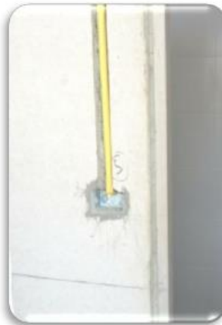
ลักษณะการติดตั้งสวิตช์ไฟฟ้า
