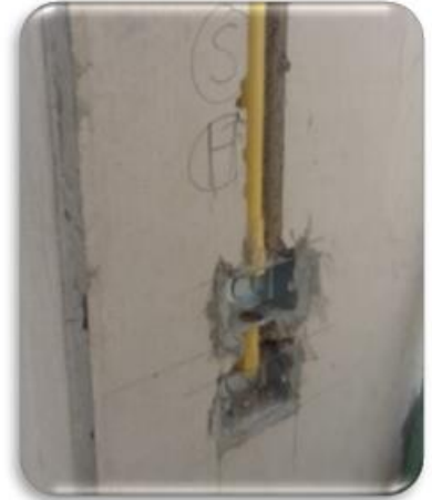
ลักษณะการติดตั้งสวิตช์ไฟฟ้า
